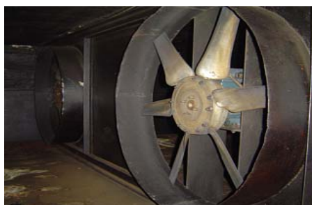
ภาพประกอบที่ 3.17 ลักษณะพัดลมในห้องอบส่วนบน
