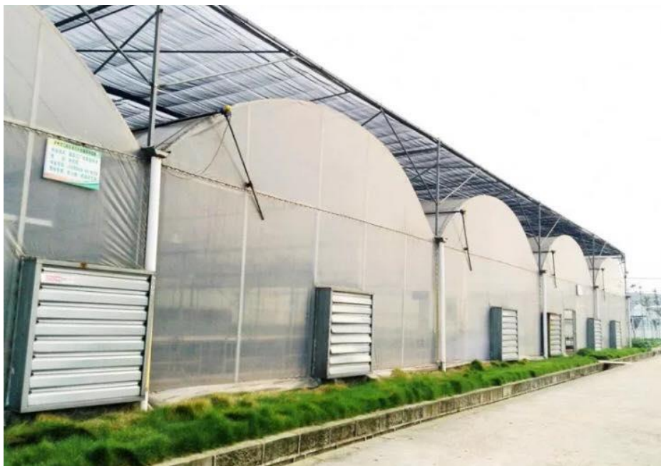
ภาพที่ 3 โรงเรือนควบคุมอุณหภูมิระบบอัจฉริยะ ที่มา: ธนากร น้ำหอมจันทร์ (2558)
