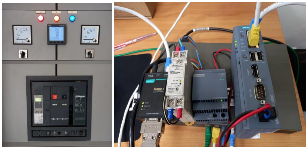
ภาพที่ 46 อุปกรณ์ระบบตรวจวัดการใช้พลังงานไฟฟ้า
