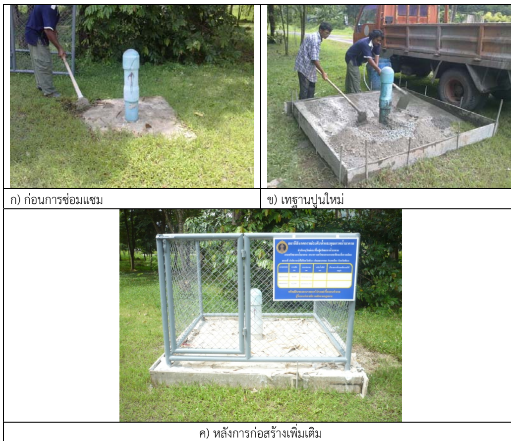
รูปที่ 4-8 การก่อสร้างสถานีสังเกตการณ์เพิ่มเติม สำนักงานป่าไม้จังหวัดพังงา ต.ตากแดด อ.เมือง จ.พังงา
