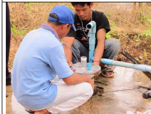
ค) ประกอบชุดปากบ่อกับชุดฝาปิดปากบ่อเข้าด้วยกัน ชั้นน๊อตยึด จำนวน 8 ชุด ให้แน่น
