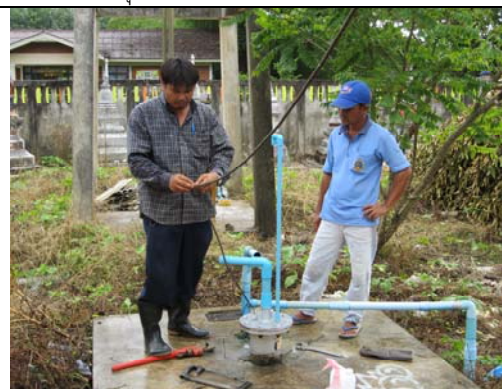
ง) ประกอบท่อระบายอากาศเข้ากับชุดฝาปิดปากบ่อ และประกอบสายไฟเครื่องสูบน้ำเข้ากับตู้คอนโทรลเดิม
