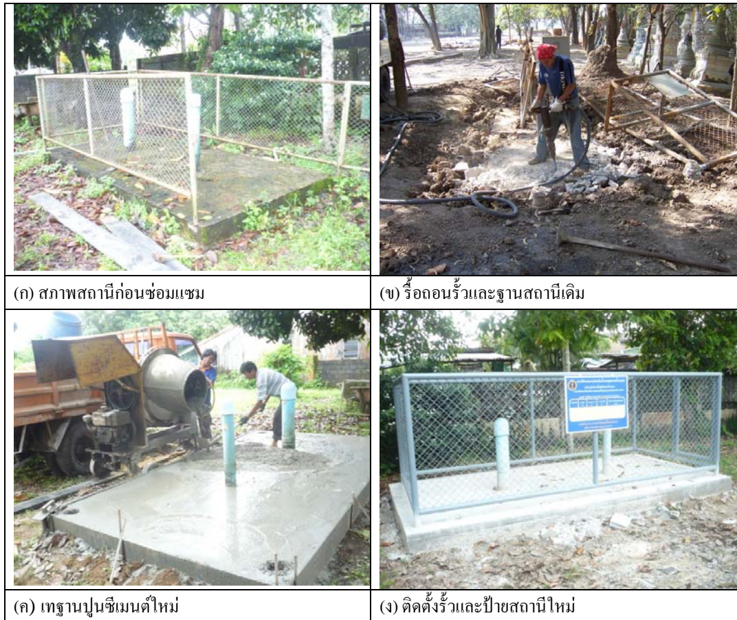
รูปที่ 3-12 แสดงขั้นตอนการซ่อมแซมสถานีสังเกตการณ์
