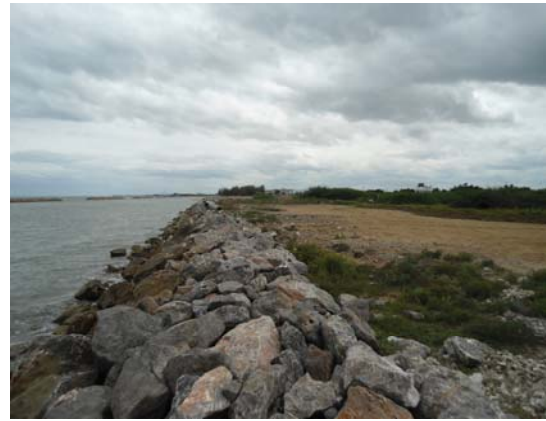
(ข) ความลาดชันที่ปะทะคลื่นค่อนข้างชัน และมีเขื่อนป้องกันคลื่นนอกชายฝั่งในพื้นที่ศึกษา
