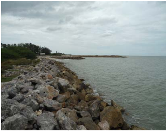
(ก) เขื่อนหินทิ้งริมชายฝั่งบริเวณทิวศไต้ จากปากคลองบางกุกุฬา
