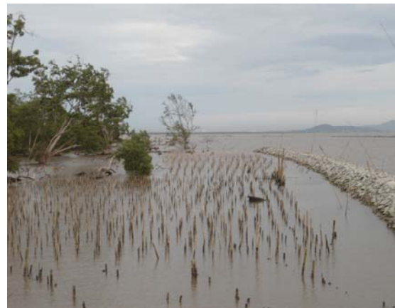
(ฉ) ปัจจุบันมีเขื่อนป้องกันคลื่นนอกชายฝั่ง เพื่อป้องกัน พื้นที่ด้านหลัง ซึ่งเคยเกิดปัญหาการกัดเซาะ
