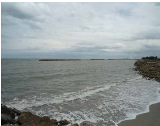
(จ) พื้นที่ที่เกิดการกัดเซาะเป็นพื้นที่เปิดโล่ง เป็นช่วงที่ไม่มี การป้องกันด้วยเขื่อนป้องกันคลื่นนอกชายฝั่ง
