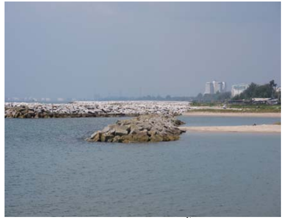
(ข) เกิดการตกตะกอนบริเวณพื้นที่ระหว่าง รอดักทรายและเขื่อนกันคลื่น
