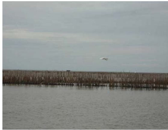
(ง) พบการปักไม้ไผ่ชะลอคลื่นบริเวณด้านหลัง แนวการวางใ้กรอกทราย
