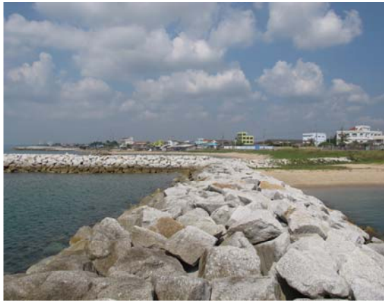
(ก) รอดักทรายรูปหางปลา (Fish tailed Groin) และมี เขื่อนกันคลื่นอยู่ระหว่างรอดักทราย
