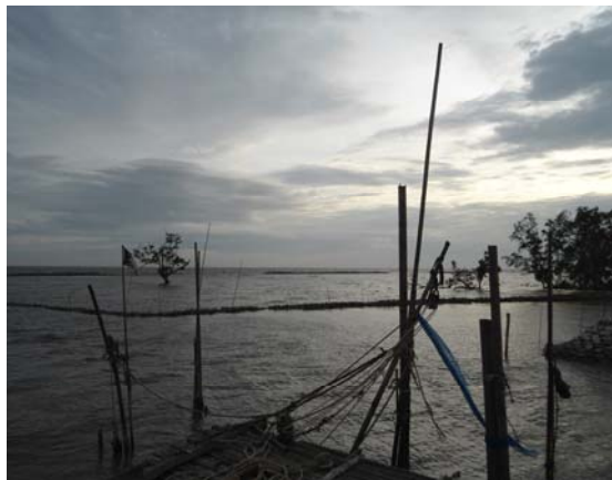
(จ) พบแนวเขื่อนหินทิ้งป้องกันการกัดเซาะบริเวณ ด้านนอกจากชายฝั่ง
