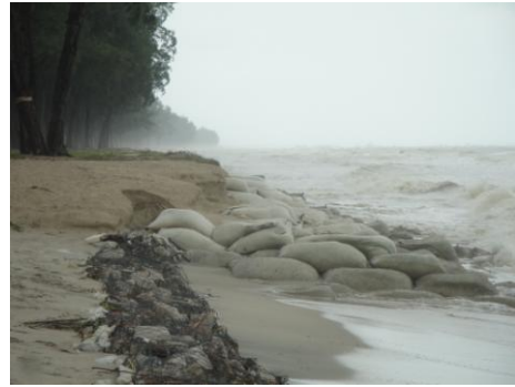
กล่องลวดใส่หินและกระสอบทรายป้องกันการกัดเซาะชายหาดสมิหลา
