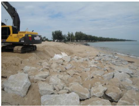
หินทิ้งโดยกลบด้วยทรายบริเวณหาดเก่าเส้ง
