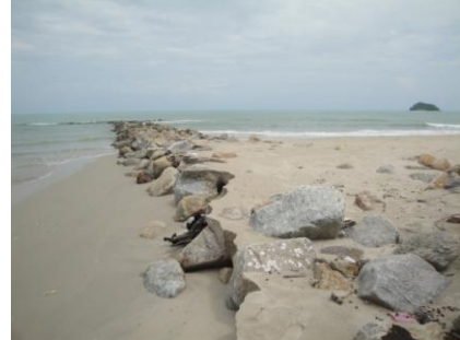
รอดักทราย บริเวณชายหาดสะกอม อ.เทพา
