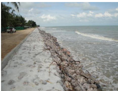
เขื่อนป้องกันตลิ่งบริเวณข้างวัดปากแตระ ต.ปากแตระ อ.ระโนด
