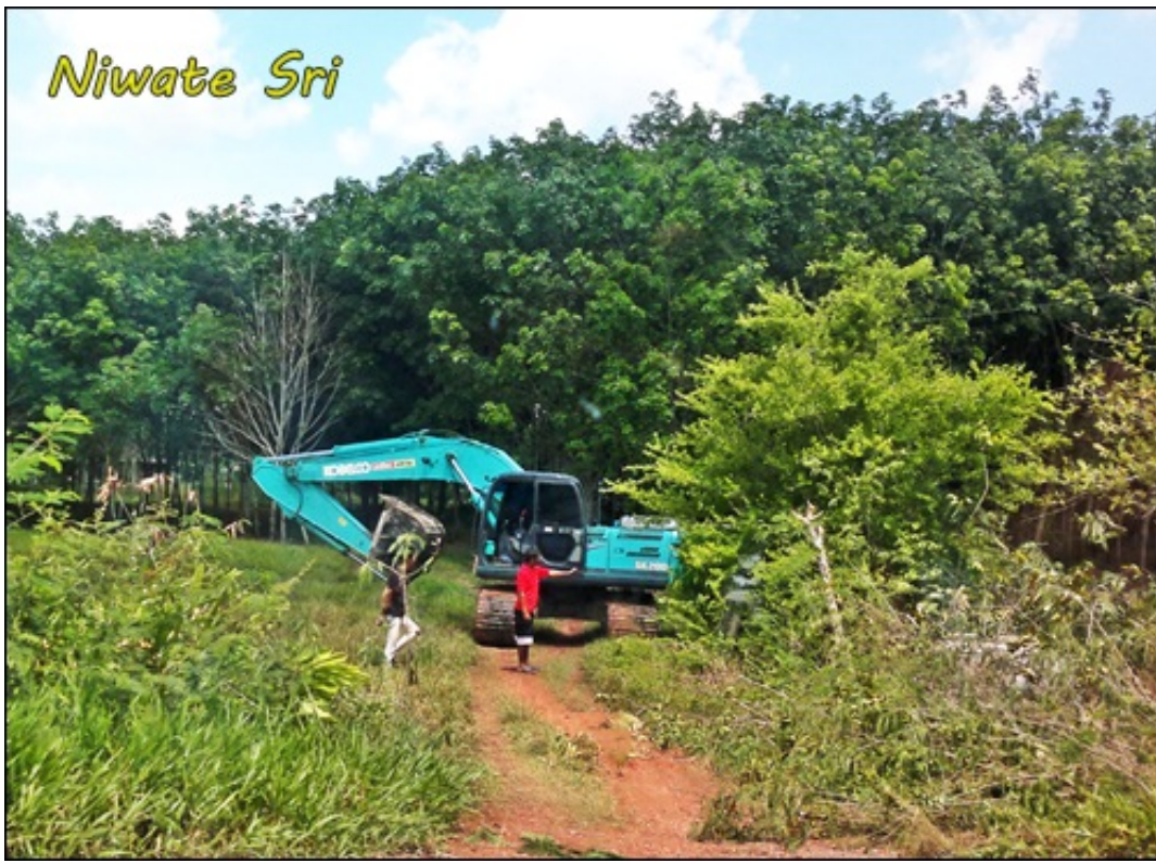
(ภาพ ขณะเข้าไปสำรวจพื้นที่แห่งหนึ่ง พบเห็นรถแบ็คโฮคันหนึ่งกำลังขุดร่องปลูกปาล์มเพ็งแล้วเสร็จ จึงรีบออกมา)
