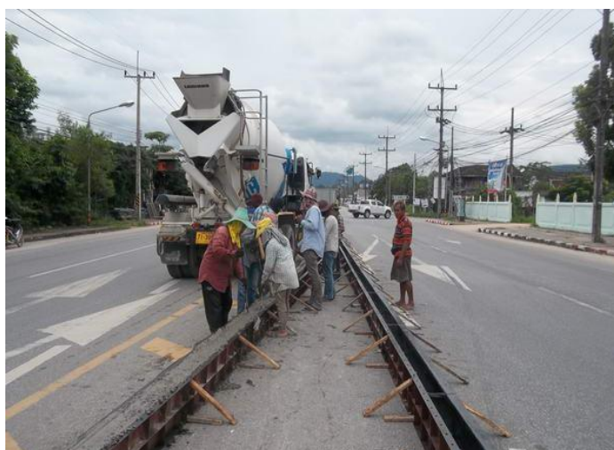
รูปที่ 3-4 ขณะดำเนินการปรับปรุงเกาะกลาง
