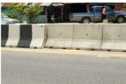
รูปที่ 14 การเปิดฐานกำแพงคอนกรีตที่ระบายน้ำ
