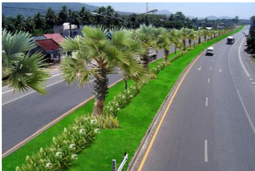
รูปที่ 2-6 เกาะกลางถนนแบบยก (Raised Median)
