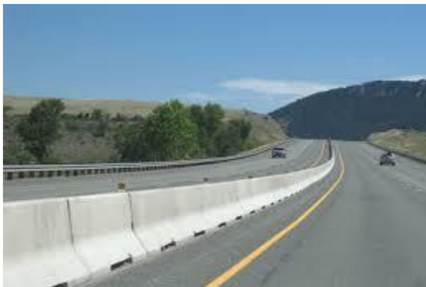
รูปที่ 2-11 เกาะกลางถนนแบบเป็นราวหรือกำแพงกัน (Barrier Median)
