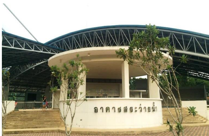
ภาพที่ 21 อาคารสระว่ายน้ำ ที่มา: ถ่ายภาพโดยผู้วิจัยวันที่ 30 พฤศจิกายน 2558
