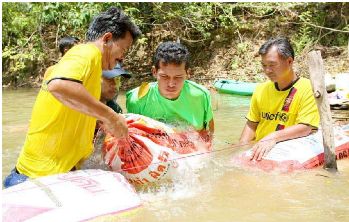
ภาพที่ 14 นำกระสอบทรายวางลำน้ำทำฝายชะลอน้ำในเขตคลอง
