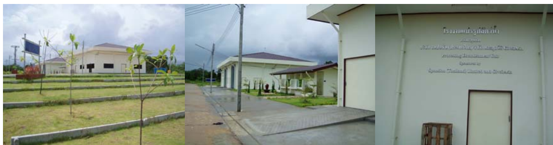
(ก)บริเวณด้านหลังอาคาร โรงงาน (ข)บริเวณด้านข้างอาคาร โรงงาน (ค)บริเวณด้านหน้าอาคาร โรงงาน
