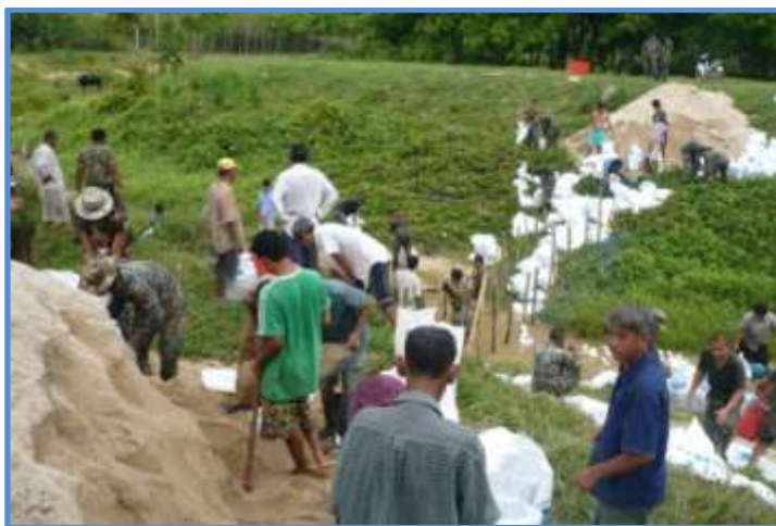
ภาพที่ 40 การสร้างฝายกั้นน้ำในชุมชน
